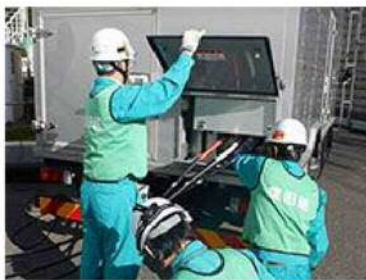
高圧発電機車による電源供給訓練
