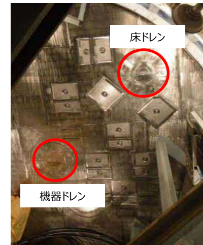
ペDESTAL内床面を上から見た写真 (コリウムシールドの外観)
