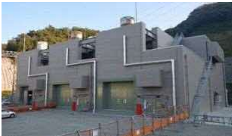
ガスタービン発電機建物 外観
