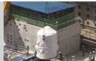
フィルタ付ベント設備
