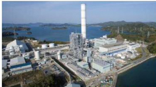
実証試験設備の様子
