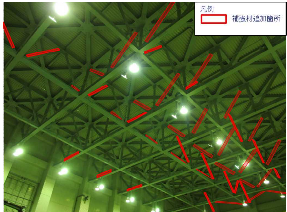
原子炉建物耐震補強工事状況
