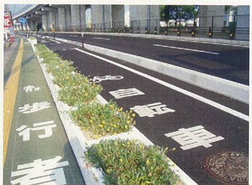
【写真】国道9号バイパス側道 における歩行者と自転 車の分離例 (島根県松江市)
