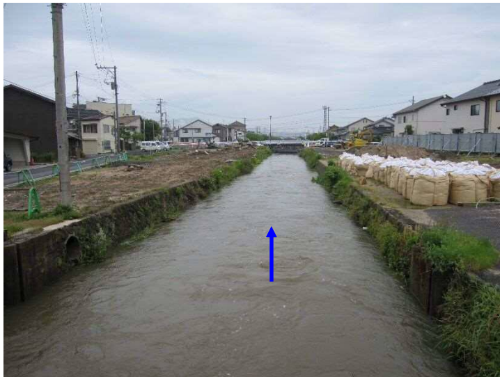
改修前(南橋から下流)
