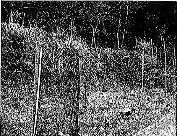
写真4 金網フェンス (鷺浦)
