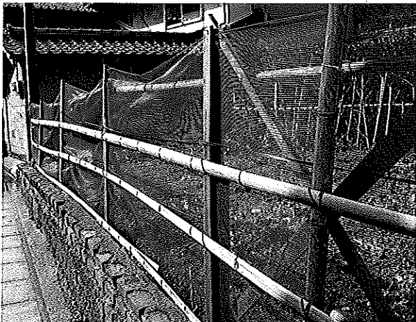
写真6 防風ネット柵 (猪目)
