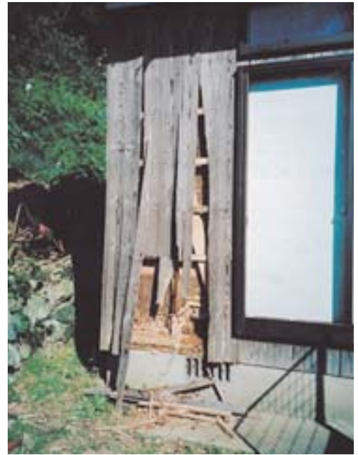
写真8 クマがミツバチの巣を食べるために壊した家壁（益田市）
