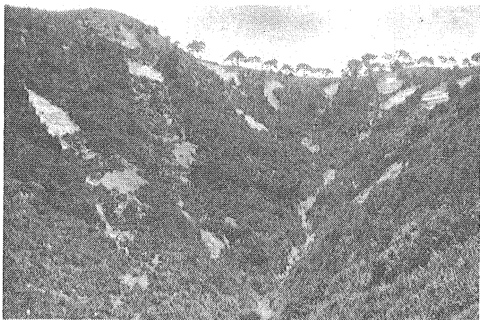
Ⅲ—12 地区 ( 斐川町仏経山 ) アカマツ 5 年生 官行造林地 一部 山腹工施工
