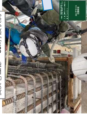
橋脚巻立部 Con打設状況
