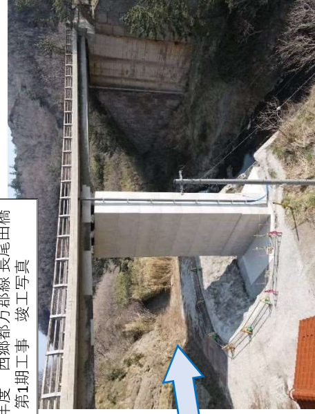
橋脚巻立部 Con打設状況
