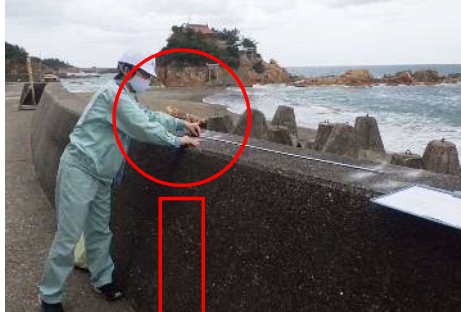
削孔間隔を確認している状況写真
